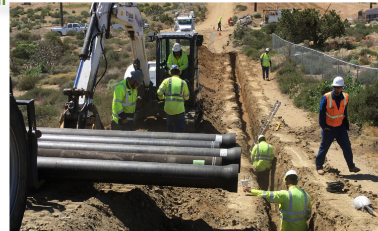
Reemplazo de Tubería en Camares Road
