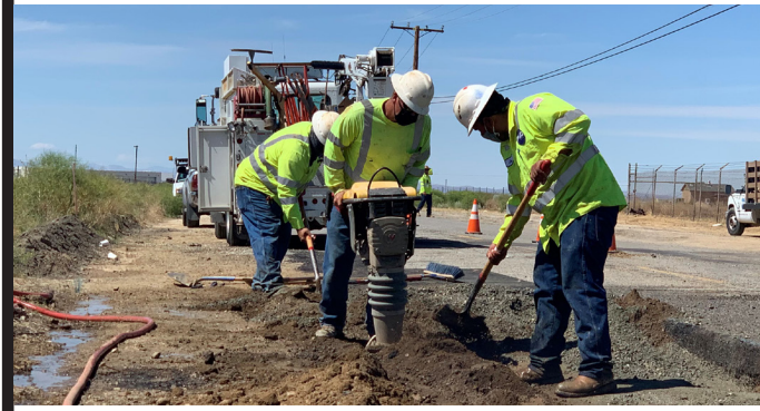
Equipo de construcción de PWD trabajando en 20th Street East y Rancho Vista Boulevard.
