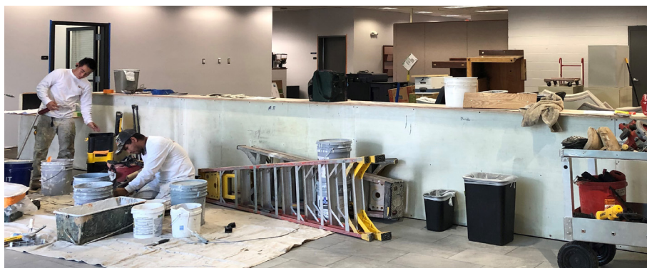
Los contratistas pintan y vuelven a revestir el vestíbulo.
